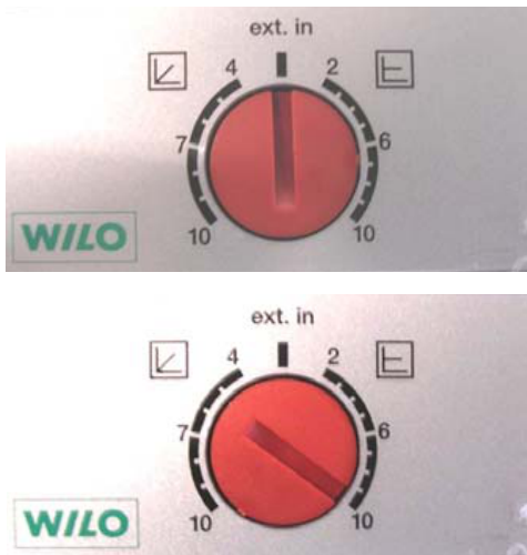
Figura 1.31 Impostazione selettore circolatore Wilo Stratos Para
